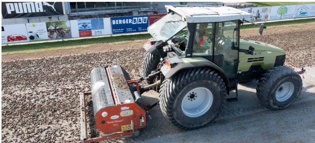
Aerifizieren anlässlich der Sanierung des Hauptplatzes
