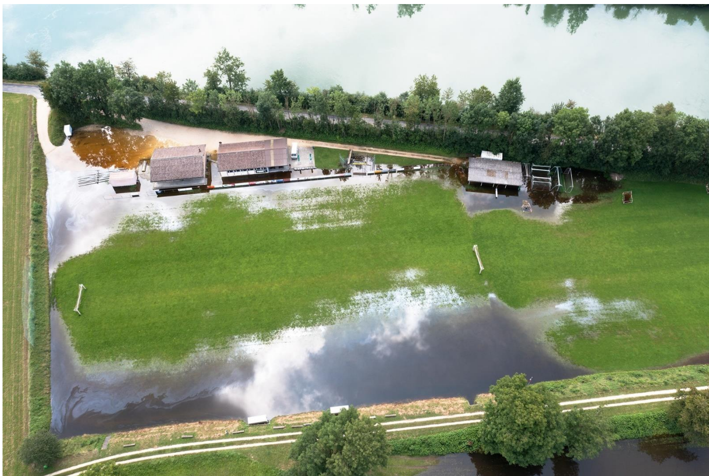
Das Hauptfeld musste gänzlich saniert werden
